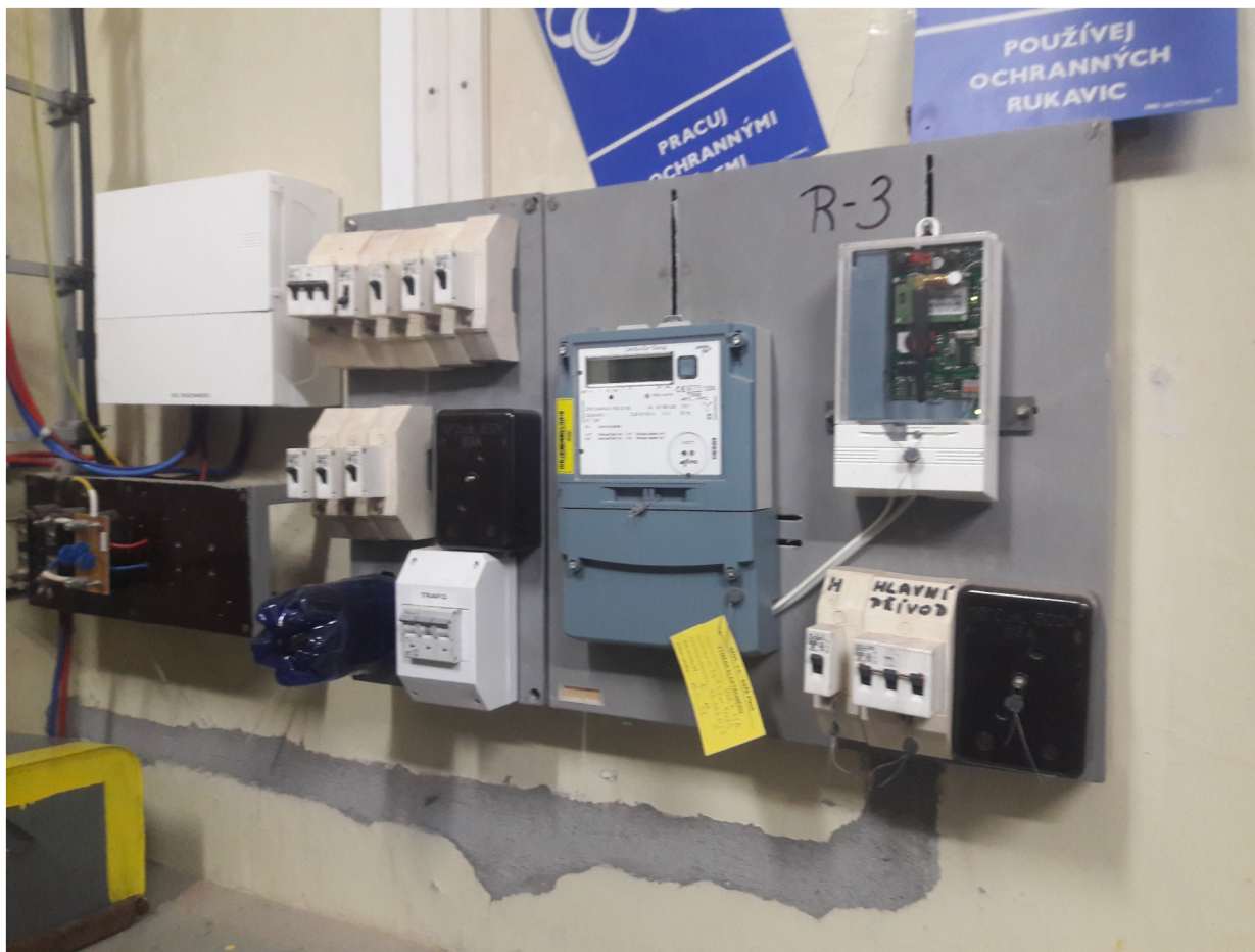
Stávající R3 - hl.jistič 3x25A. Připojí se z R1 kabelem CYKY-J 5x4
